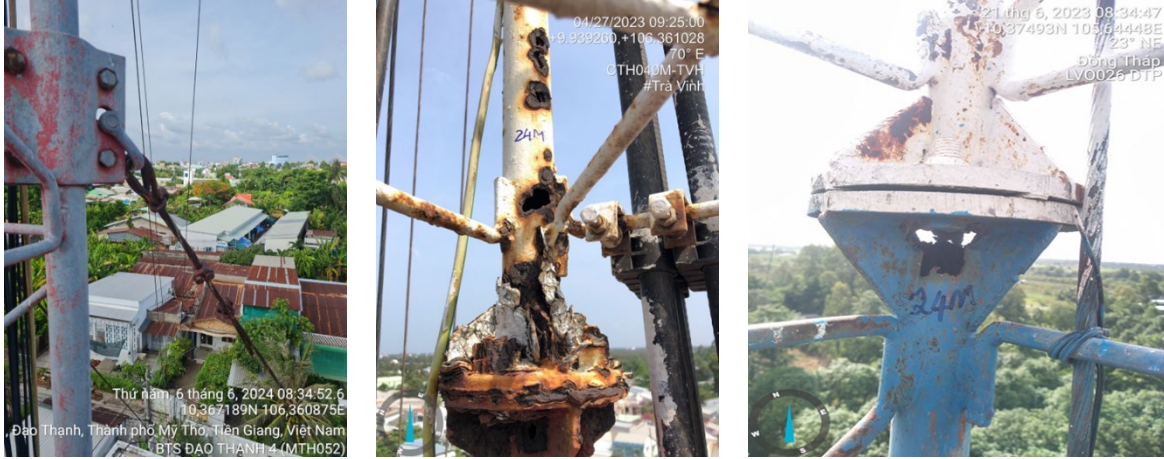
Hình 3. Các dạng hư hỏng điển hình trên trụ thu phát sóng thông tin di động (VNPT Đồng Tháp, 2023-2024)
