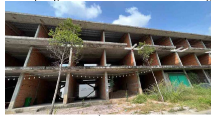
c. Công trình bỏ trống tại KDC Hưng Phú 2
